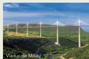
Viaduc de Millau
